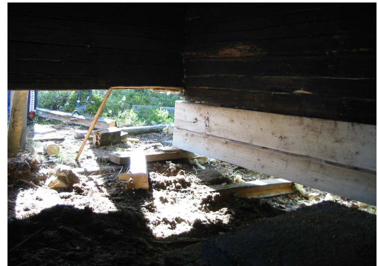
Valkeinen: Hirsien vaihto käynnissä saunalla.
